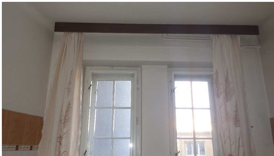
Obr. 5 Okna dřevěná kastlíková
