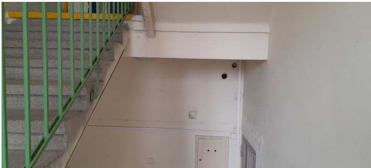
Obr. 9 Monolitické schodiště s ocelovými nosníky
