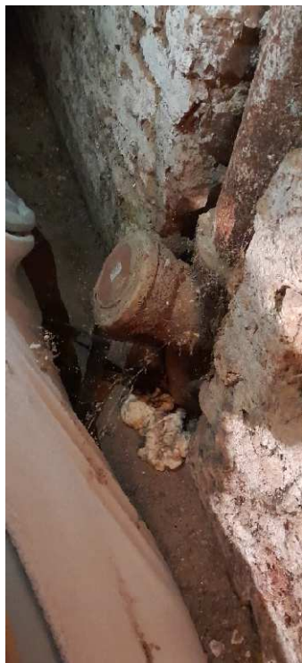
Obr. 12 Původní aktivní odpadní potrubí z trub litinových
