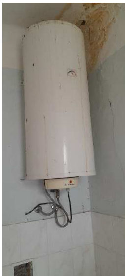
Obr. 11 Zásobníkový ohřivač Tatramat 120l elektrický v jednom z bytů
