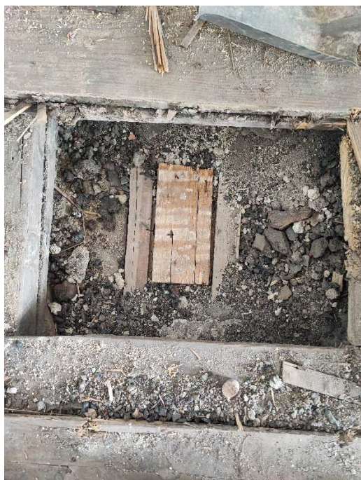
Obr. 2 Pohled na skladbu podlahy nad nosným dřevěným záklopem
